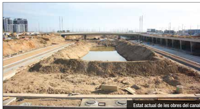
Estat actual de les obres del canal
