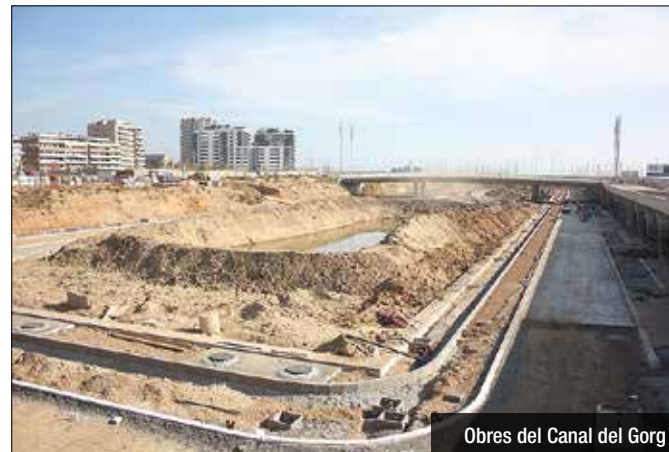
Obres del Canal del Gorg
