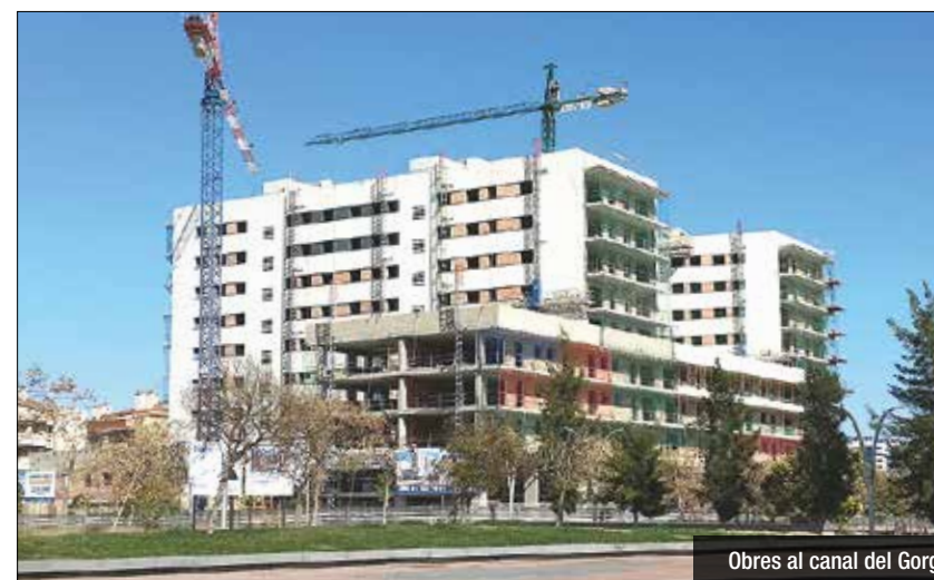
Obres al canal del Gorg
