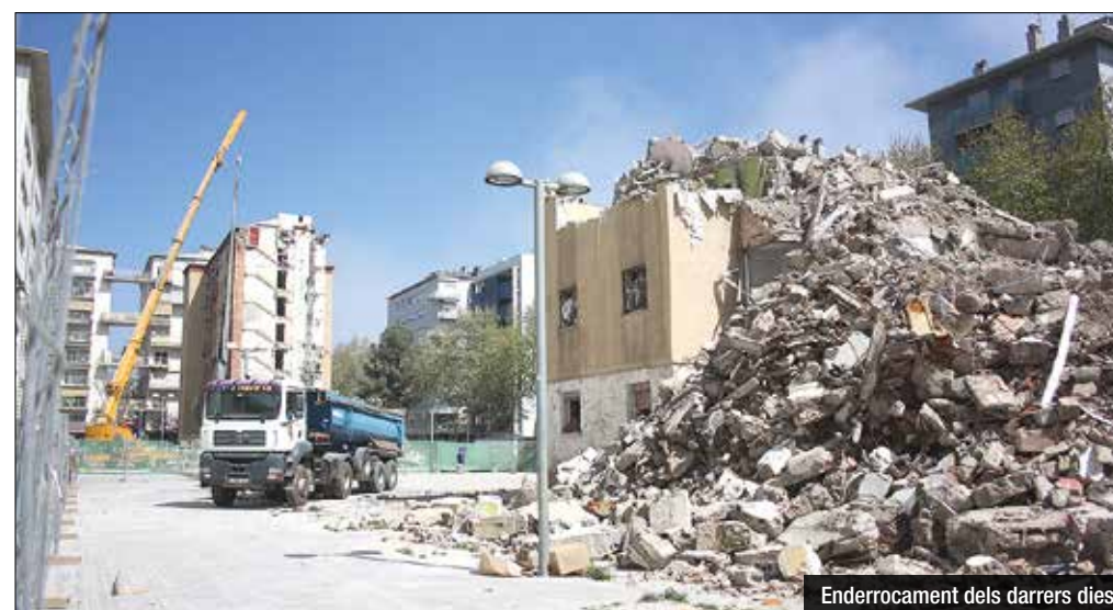
Enderrocament dels darrers dies
