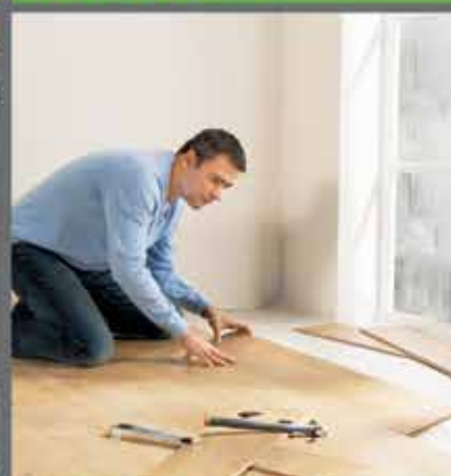
Instalación de Tarima y revestimiento vinílico
