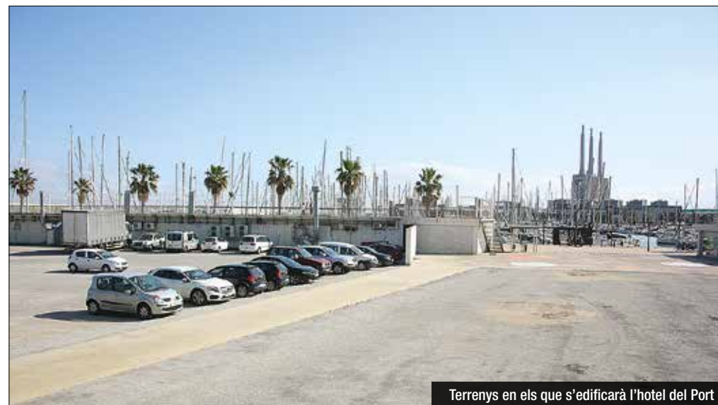
Terrenys en els que s'edificarà l'hotel del Port
