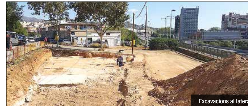
Excavacions al lateral
