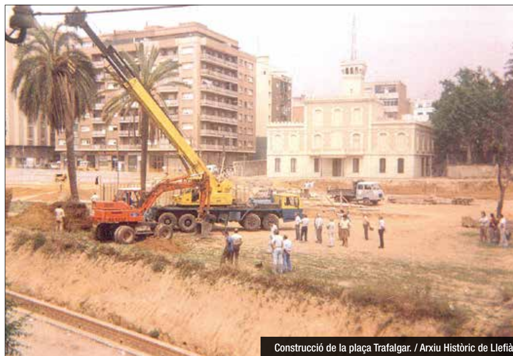
Construcció de la plaça Trafalgar. / Arxiu Històric de Llefià
