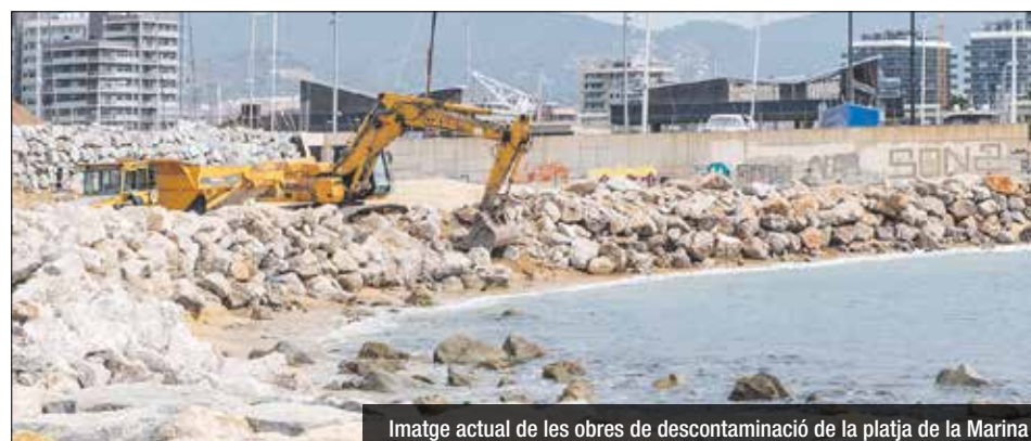
Imatge actual de les obres de descontaminació de la platja de la Marina
