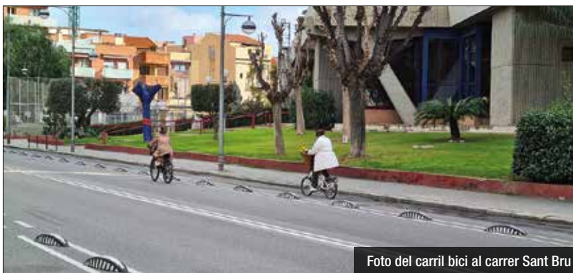
Plataforma instal·lada a la parada del bus
