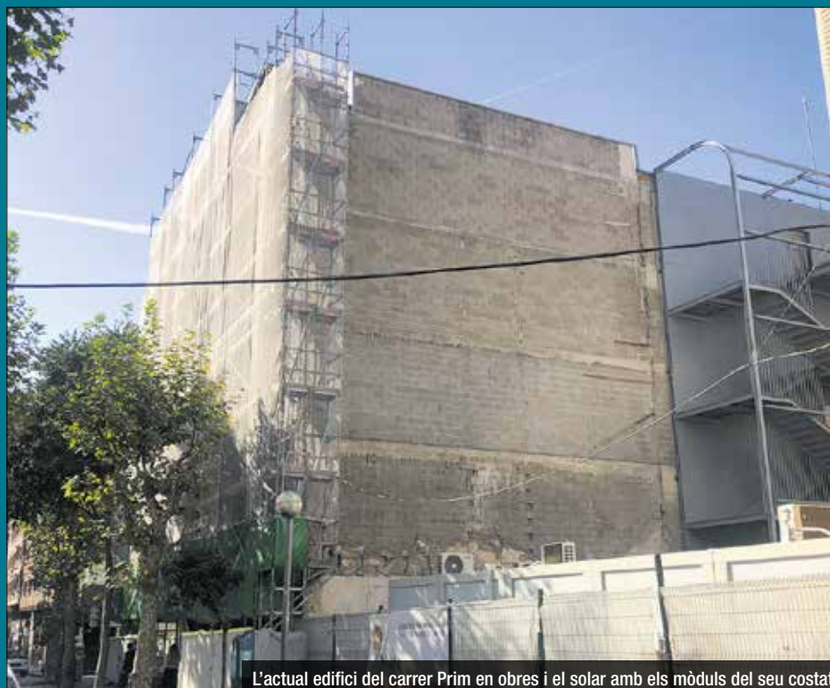
L'actual edifici del carrer Prim en obres i el solar amb els mòduls del seu costat
