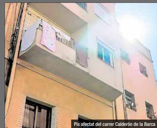
Pis afectat del carrer Calderón de la Barca
